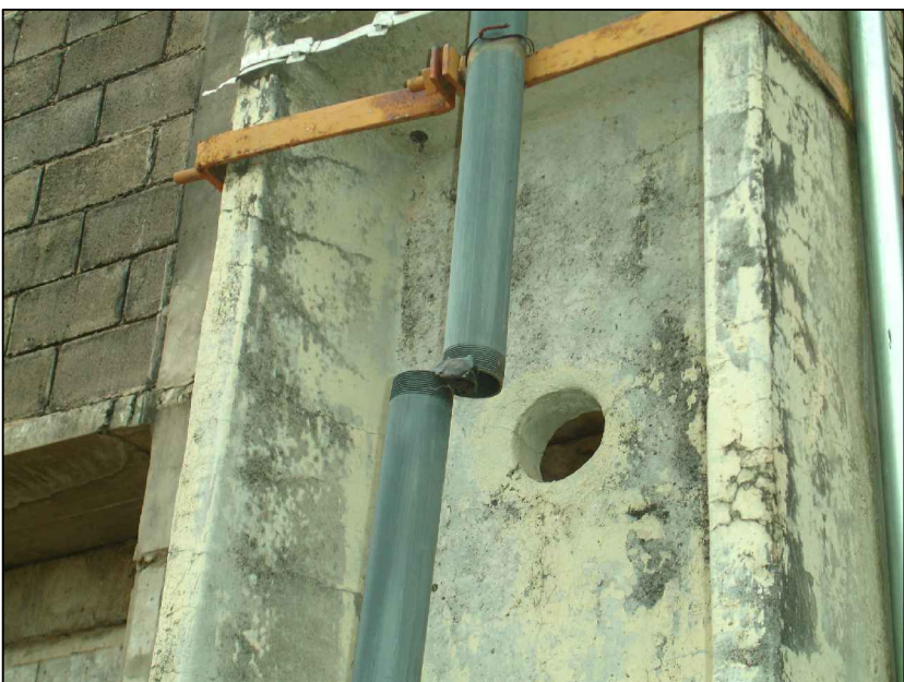
FOTO 02 - DESCIDA DO SPDA A SER REVISADO
