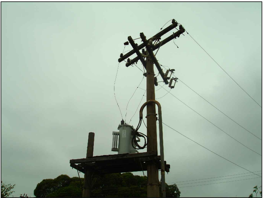
FOTO 07 - Transformador de 30KVA a ser substituído por 225KVA
