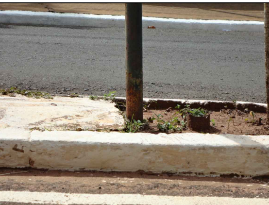
BASES DOS POSTES COMPROMETIDAS POR CORROSÃO
