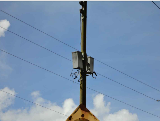
REACTORES EXTERNOS SEM ALOJAMENTO ADEQUADO
