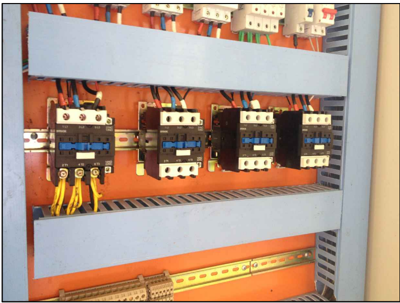
FOTO 03 - Detalhe dos contadores 01 a 04 existentes
