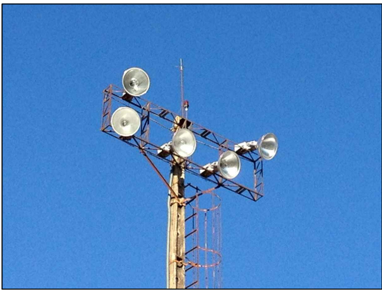
FOTO 07 - Vista dos 05 projetores existentes por torre
