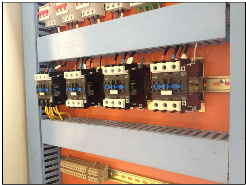
FOTO 04 - Contadores 02 a 04 específicos para conexão dos novos projetores
