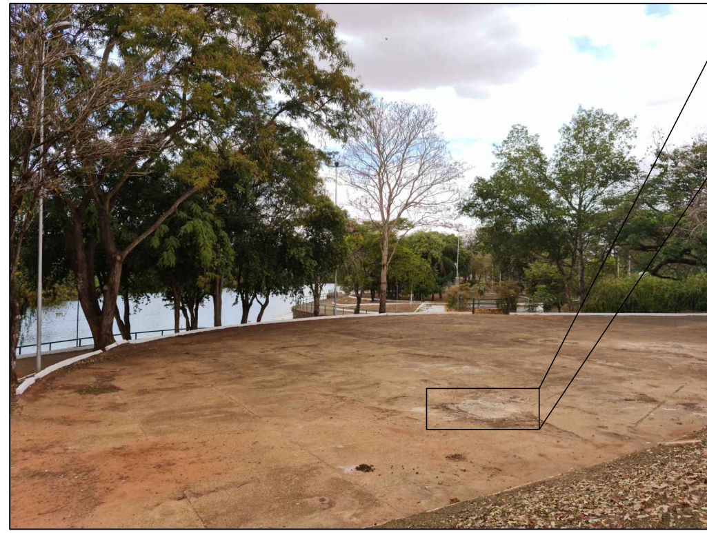
PONTO 6—ÁREA LIVRE PARA O FOOD PARK — TODA PAVIMENTAÇÃO ESTÁ DANIFICADA SEM CIMENTO ADEQUADO PARA ESCOAMENTO DE ÁGUAS PLUVIAIS CAUSANDO EMPOÇAMENTOS — ILUMINAÇÃO ESCASSA — NÃO HÁ LIXEIRAS NO LOCAL — NÃO HÁ PONTOS ENERGIA ELÉTRICA PARA CONEXÃO DOS CARRINHOS DE AMBULANTES
